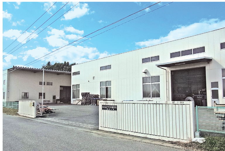
パンチング加工技術を集積し続けてきた国内のマザー工場
